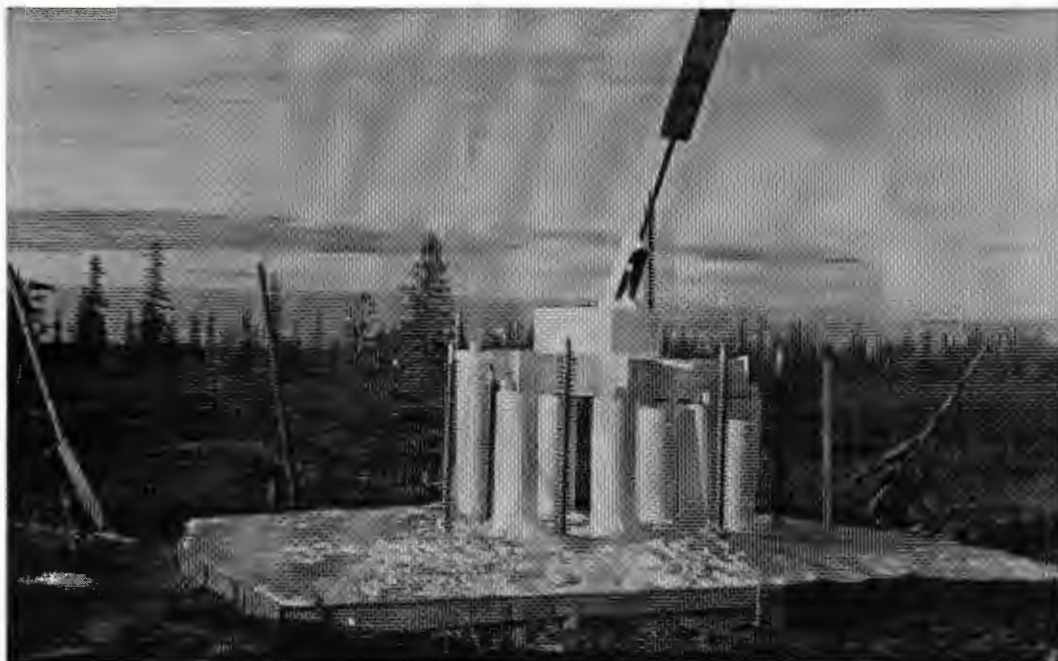
Рис. 2. Общий вид фундамента оттяжек.
