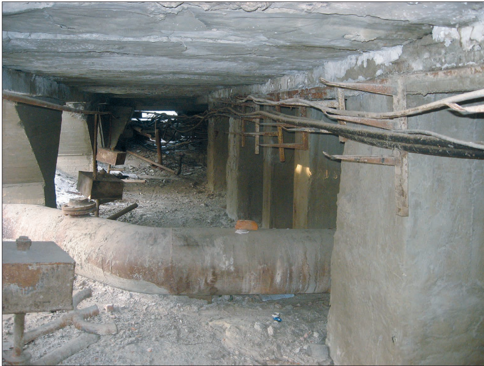
Рис. 6. Проветриваемое подполье под главным корпусом ЯТЭЦ.
