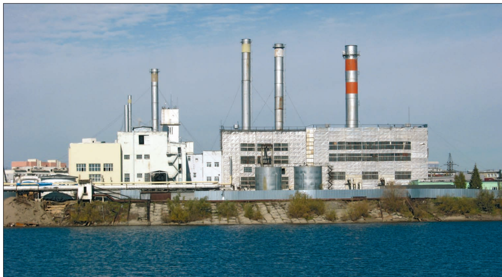
Рис. 1. Общий вид Якутской ТЭЦ.
