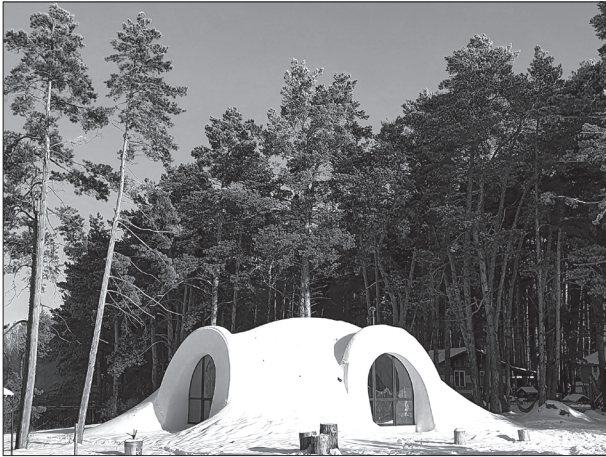
Рис. 5. Купольное здание из гранулированной пеностеклокерамики.
