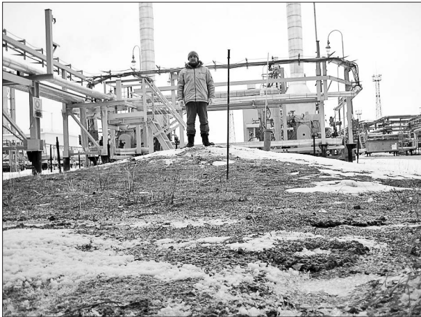
Рис. 7. Бугор пучения на участке локального заземления надмерзлотных вод после схода снежного покрова в июне.
