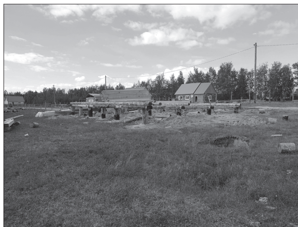
Рис. 10. Строительство дома на пятиметровых лиственничных сваях, микрорайон Первая пашня, с. Улахан-Ан.
