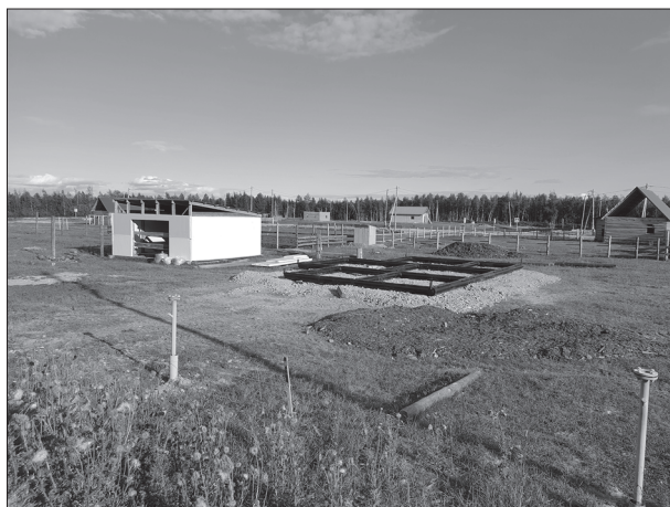
Рис. 9. Отсыпка коренными породами и металлическая рама в качестве основания будущего жилого дома в микрорайоне Чэчир, с. Улахан-Ан.
