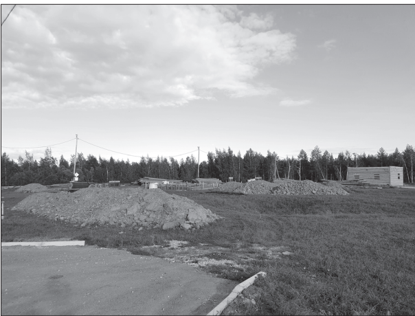
Рис. 8. Подготовка к строительству на участке с развитием термокарста, микрорайон Чэчир, с. Улахан-Ан.
